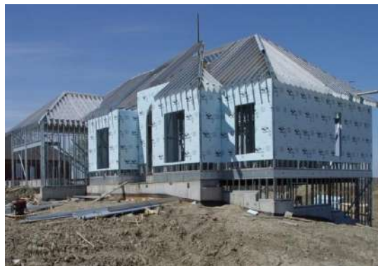
شکل ۱-۳- تصاویری از ساختمان‌های شش و دو طبقه در حال ساخت در شهر تورنتو در کانادا
