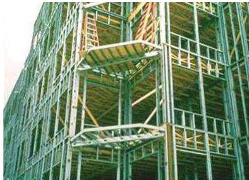
شکل ۱-۵- نمونه‌ای از سازه سیستم ساختمانی سبک فولادی و تمام شده
