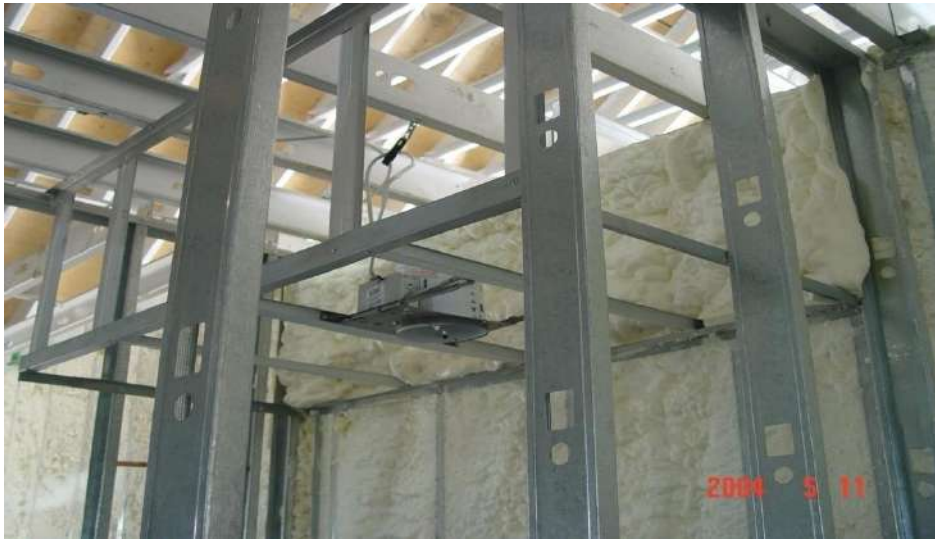
شکل ۱-۱۳- نمونه‌ای از قطعات اصلی سیستم LSF
